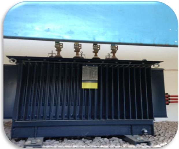
Foto 1: Imagen de un transformador eléctrico.
